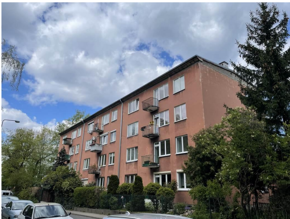
Fot. 1. Widok elewacji od strony południowo-wschodniej.
