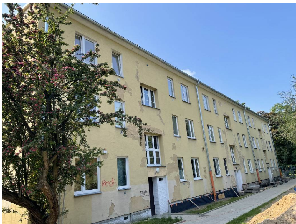
Fot. 2. Widok elewacji od strony północno-zachodniej.
