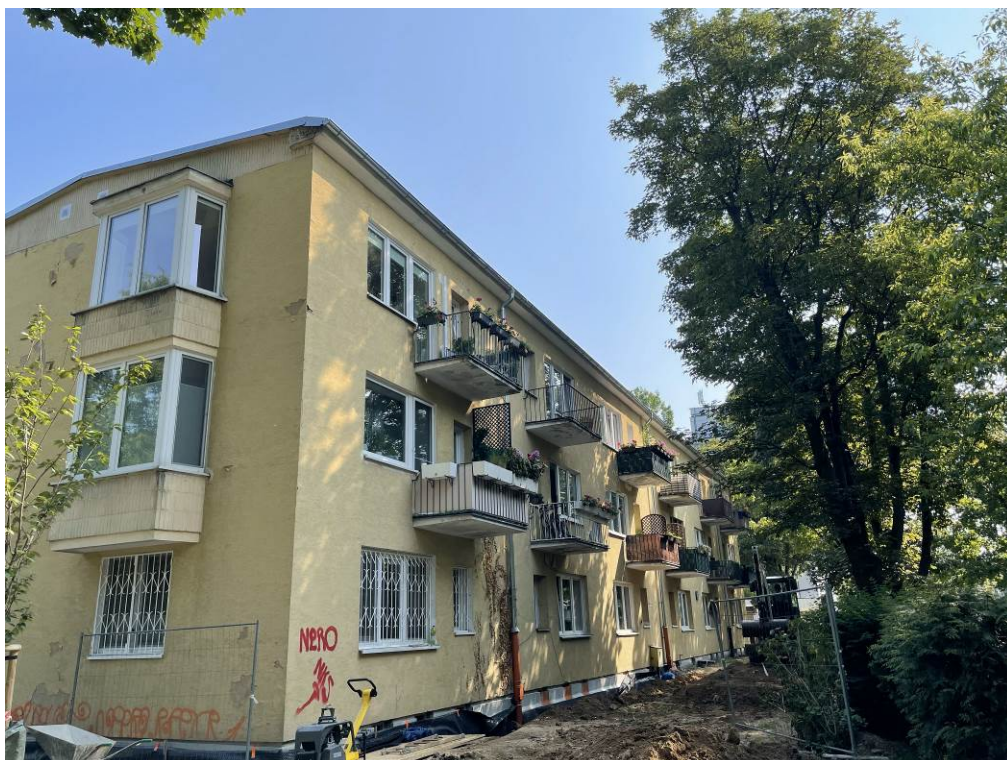
Fot. 1. Widok elewacji od strony południowo-wschodniej.
