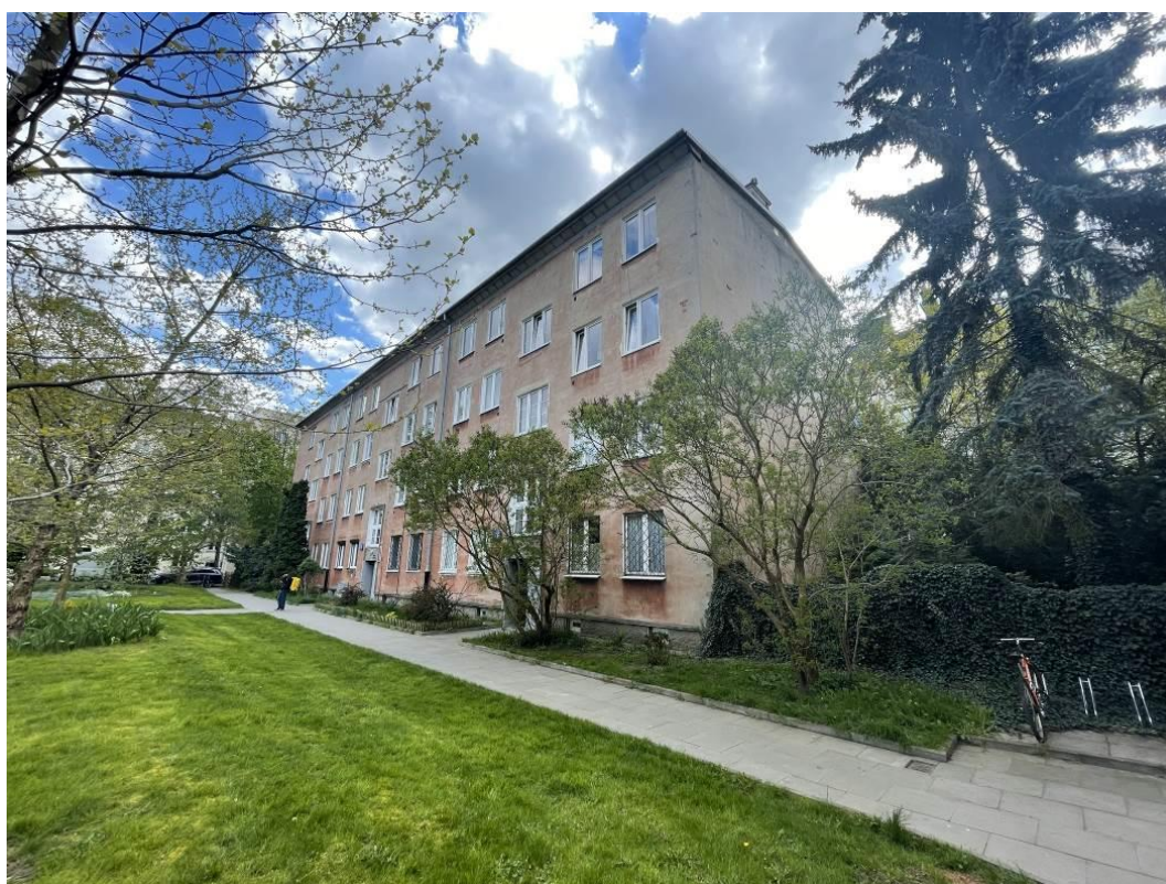
Fot. 2. Widok elewacji od strony północno-zachodniej.
