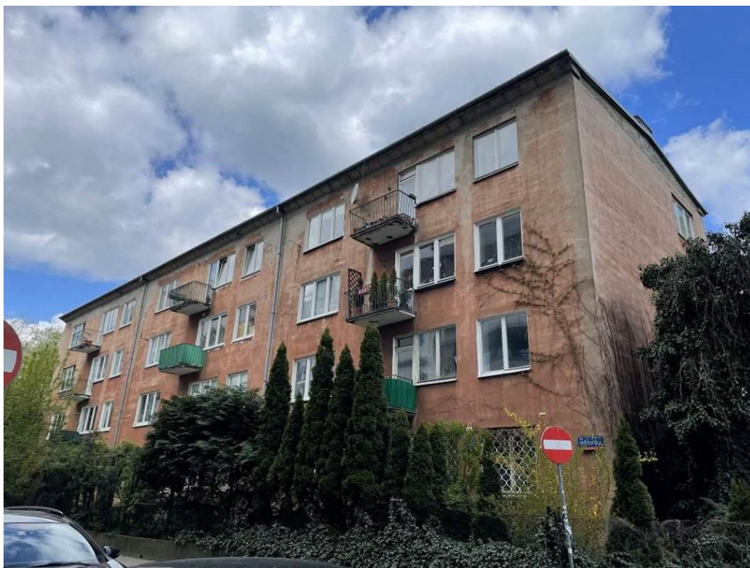
Fot. 1. Widok elewacji od strony południowo-wschodniej.
