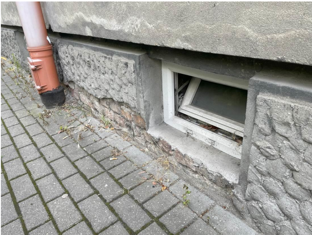
Fot. 6. Widok ścian elewacyjnych w poziomie cokołu.
