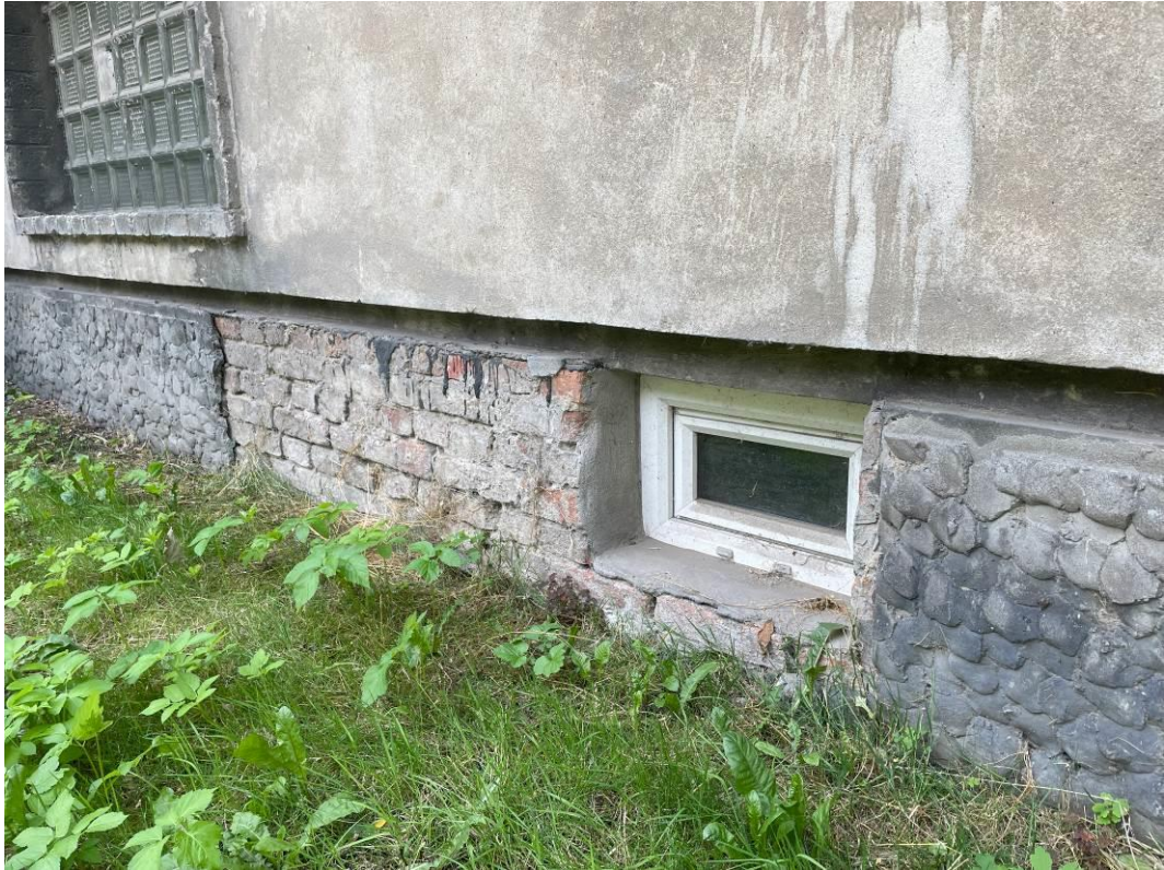
Fot. 5. Widok ścian elewacyjnych w poziomie cokołu.
