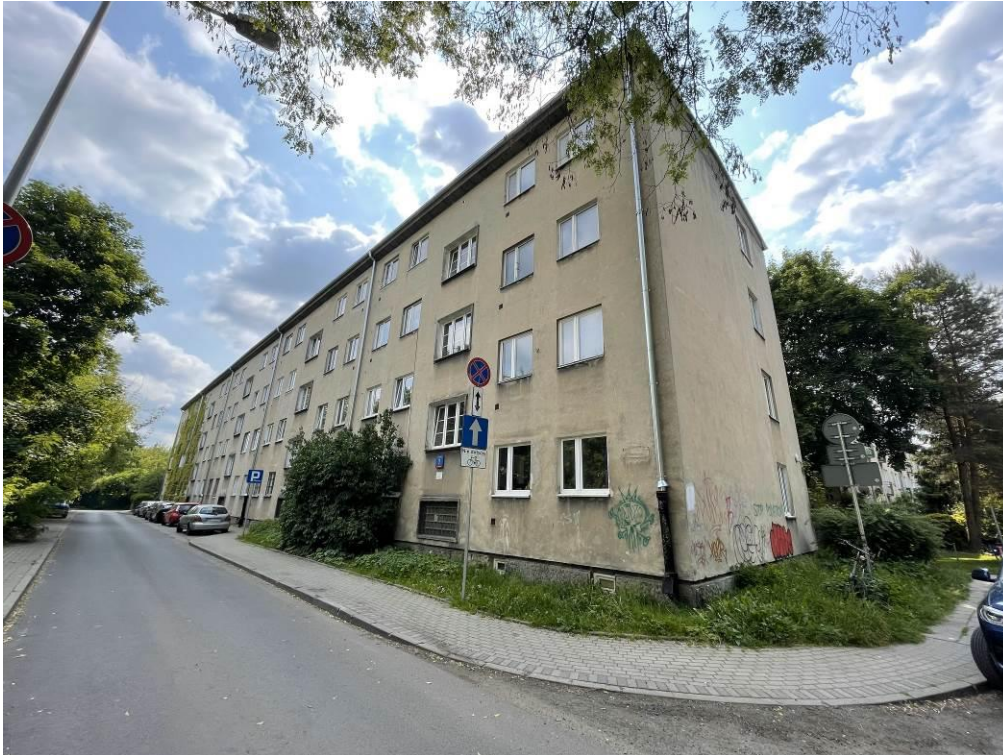
Fot. 4. Widok elewacji od strony północno-zachodniej.
