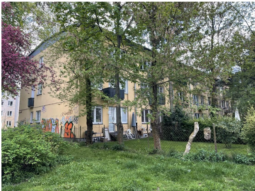
Fot. 2. Widok elewacji od strony południowo-zachodniej.
