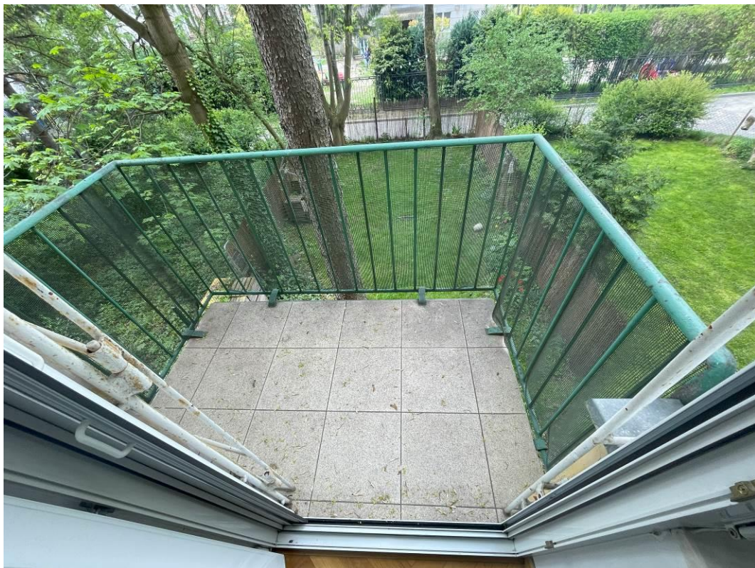
Fot. 5. Widok płyty balkonowej od góry.
