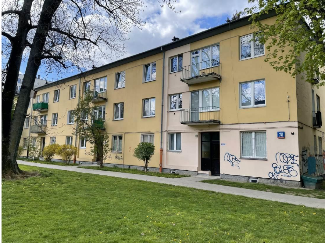
Fot. 1. Widok elewacji od strony północno-wschodniej.
